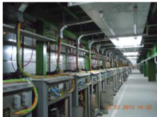
由杭安公司何根义项目部承接的巨石集团埃及工厂自动控制项目的电气安装工程位于埃及苏伊士经贸合作区。该项目为年产量 8 万吨的玻璃纤维生产线电气安装，施工内容为：配料、窑炉、电助熔、拉丝成型、烘箱、烙纱、浸润剂等部分的电气设备的安装及控制电箱、电力电缆的敷设。本工程属交钥匙工程，合同价为 510 万元。巨石集团是全球最大的玻璃纤维专业制造商，并设立了多个生产和贸易型控股海外子公司。何根义项目部和巨石集团于 2004 年建立了合作关系，陆续承接了拉丝机控制柜集成安装工程、224 工程电气安装工程、101-6 工程配电系统安装工程等项目。该项目的承接也是杭安公司第一次涉足埃及市场，对于积累海外工作经验具有重要意义。
